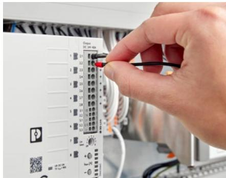
*Dank Push-in-Anschluss-technik, integrierten Beschriftungsfeldern und einem intuitiven Inbetriebnahmekonzept sind die Geräte schnell einsatzbereit*
